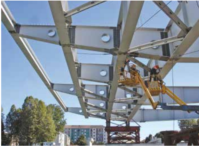
10. Le fasi di montaggio dell'impalcato stradale
