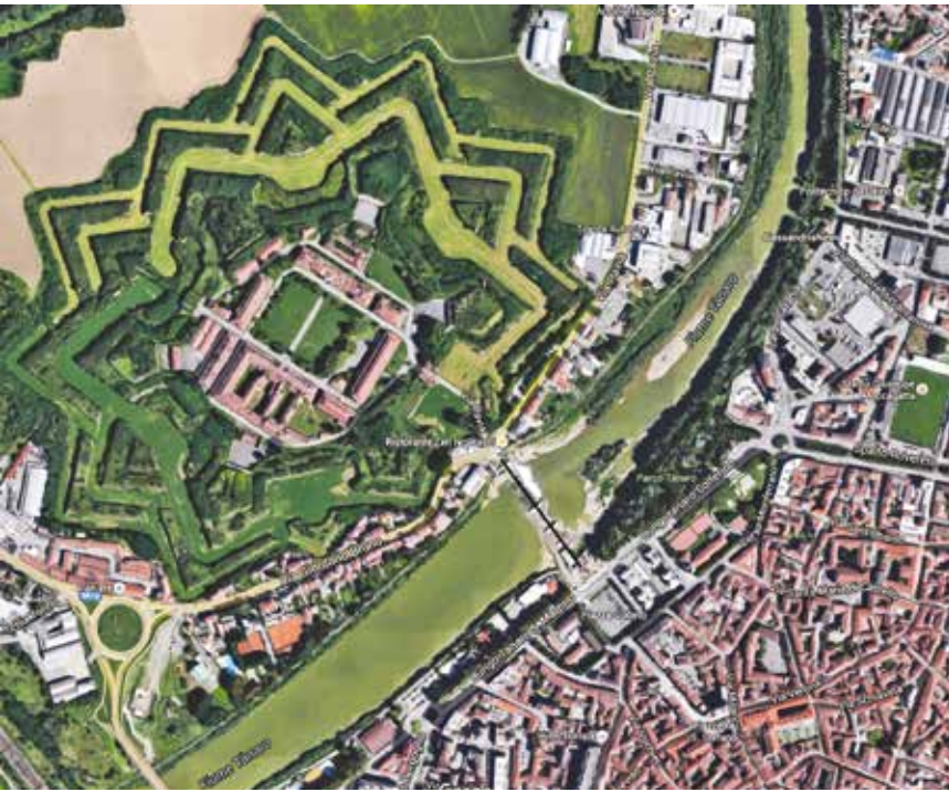
3. Una foto satellitare dell'area urbana d'inserimento del ponte Meier
