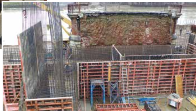
7. L'armatura della spalla
