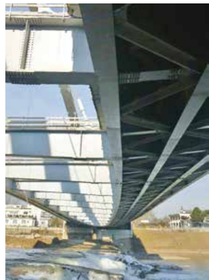
8. Vista della struttura dell'impalcato dall'alveo del fiume, lato spalla B
