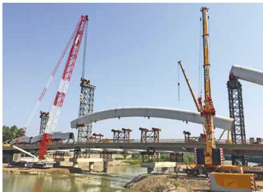
14. Le fasi di montaggio in quota dei maxi-conci dell'arco
