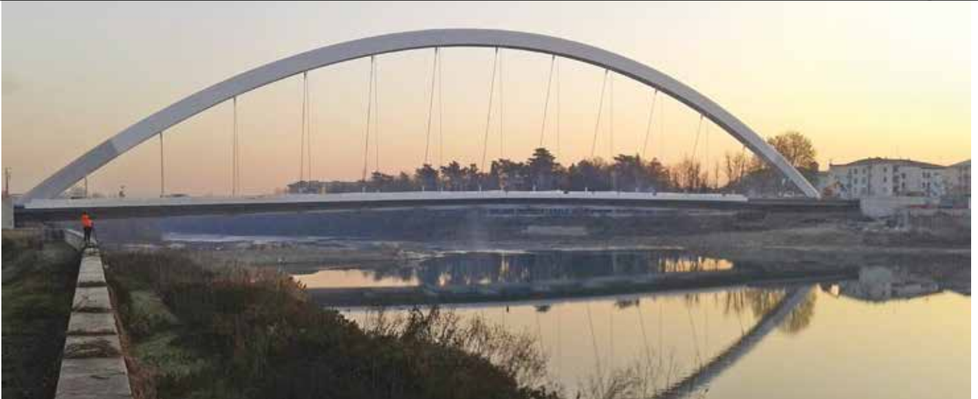
15. Vista frontale del ponte
